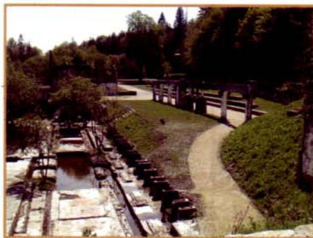
Le site des papeteries Vallée. En haut, la traversée des anciens ateliers. En bas, le jardin d'eau et les arcades. Ph. © Agence Laure Planchais.
